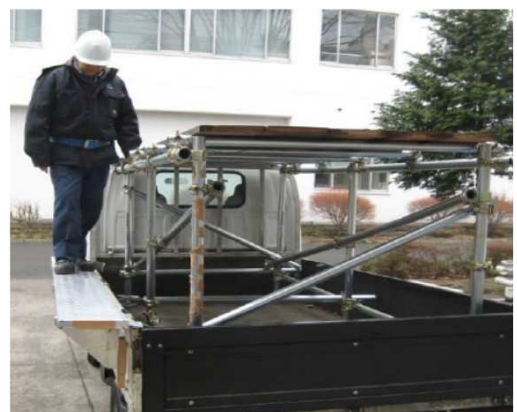
簡易作業床をあおりに取付(厚生労働省ホームページ)
